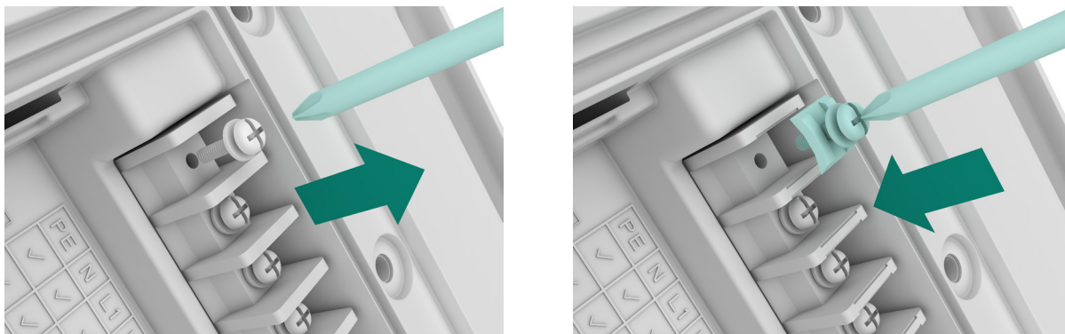
Figura 9 Installazione del morsetto a vite
